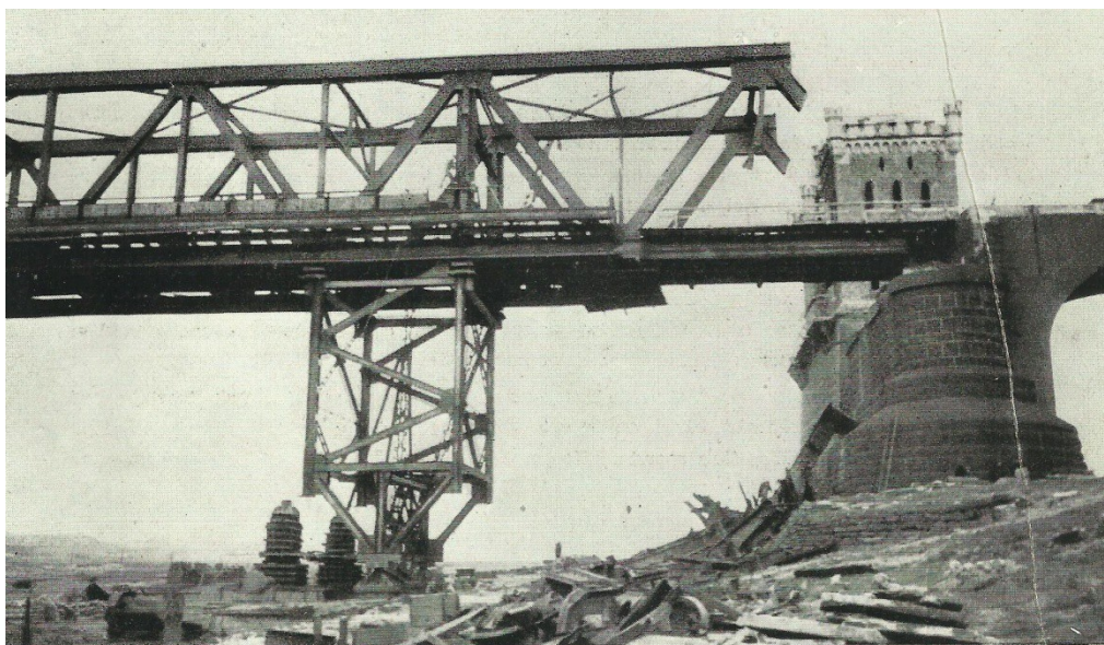
INSTANDESETZUNG NACH BOMBENSCHÄDEN IM MAI 1944
